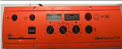
Heizungsregler Hoval Toptronic 23S usw.
